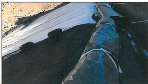
Detalle impermeabilización balsa mediante instalación lámina PEAD
